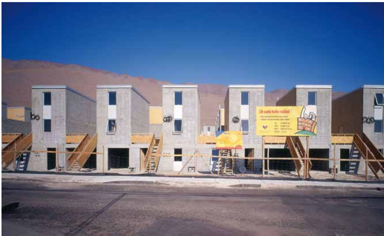
Logements sociaux livrés bruts autorisant extensions et finitions en autoconstruction au Chili, Elemental architectes
